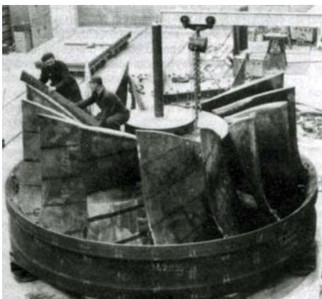
**4 pav.** Frenso turbinos rotoriaus, sveriančio 67 t, montavimas 1957 m. Sujungimų briau-nų apvirinimui ir galutiniams suvirinimui buvo naudojamas rankinis lankinis suvirinimas ESAB OK R6 elektrodais.
