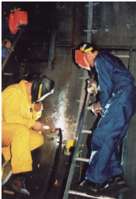
5 pav. Cilindro suvirinimas iš vidaus vertikaliai aukštyn. Panaudotas Railtrac ir visose erdvinėse padėtyse taikoma rutilinė viela su fluso užpildu – OK Tubrod 15.15.
