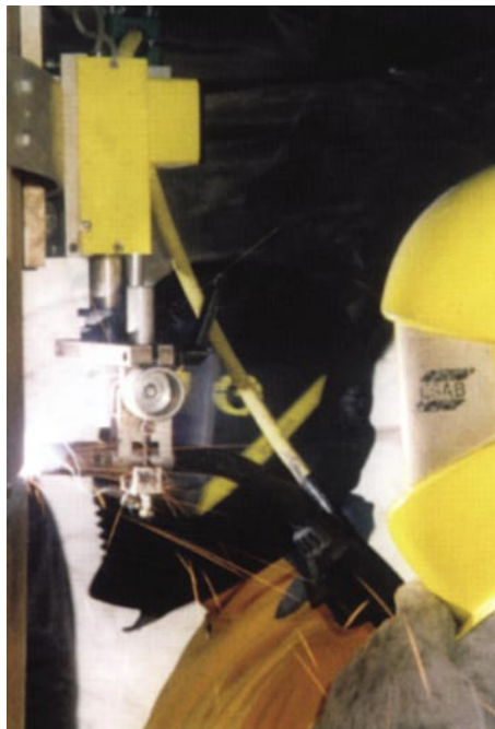
8 pav. Pakabinamo tilto Argentinoje plieninių sijų suvirinimas. Panaudojamas Railtrac ir bazinė viela su fluso užpildu OK Tubrod 15.27. Žr. žurnalo „Suvirinimas“ 2004 m. Nr. 1(6), p. 10-11.
