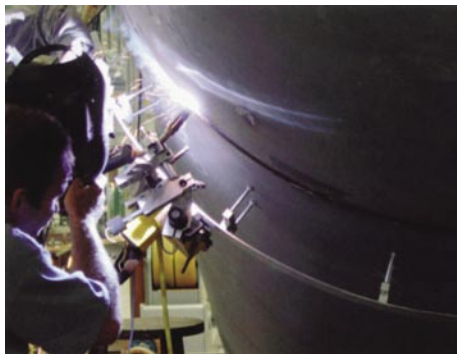
7 pav. Benfica stadiono Lisabonoje pakabinamo stogo konstrukcijos suvirinimas. Panaudotas Railtrac ir visose erdvinėse padėtyse taikoma viela su fluso užpildu PZ6113. Žr. žurnalo „Suvirinimas“ 2004 m. Nr. 1(6), p. 3-5.
