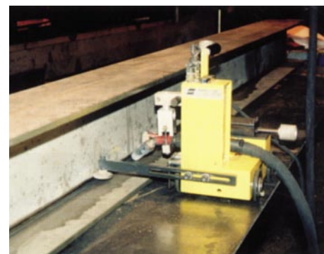
4 pav. Nerūdijančio plieno fasado sijų gamyba. Jos skirtos komercinio centro pastatui, kurio architektas tikriausiai nepritarė rankinio suvirinimo technologijos panaudojimui. Kampinės siūlės PB padėtyje. Panaudotas Miggytrac ir rutilinė viela su fluso užpildu – OK Tubrod 14.31.
